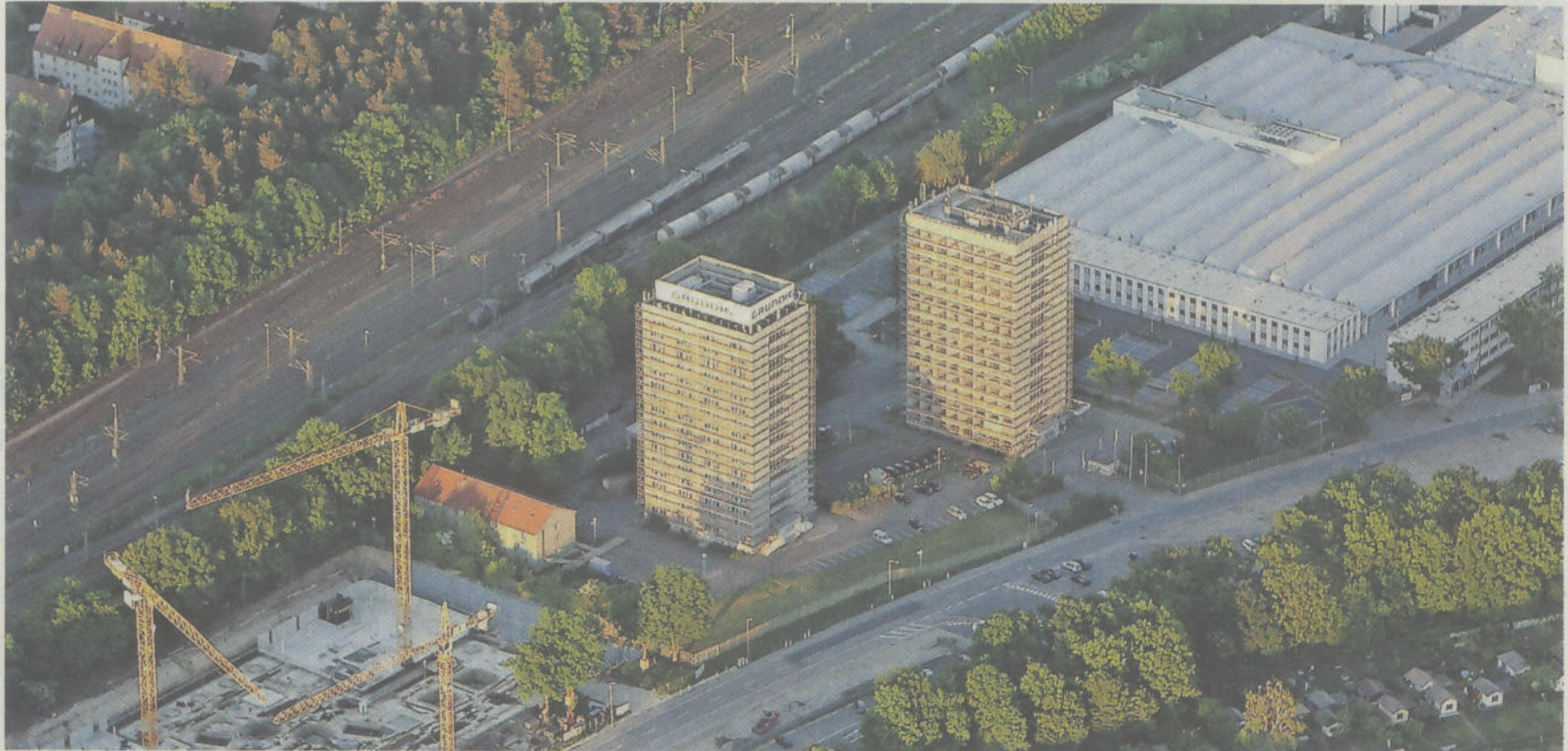
Seit Jahren eingerüstet: Bald sollen die beiden Grundig-Türme an der Beuthener Straße für Geschäftsreisende umgebaut werden.
